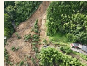
ドローンによる被災箇所調査
