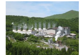
九州電力(株)八丁原発電所
