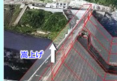
安岐ダムの再生
