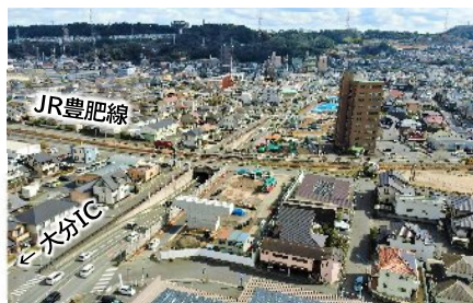
庄の原佐野線（下郡工区）整備状況
