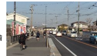
万田四日市線の整備状況（中津市）
