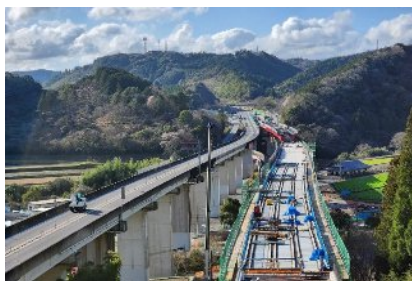
4車線化が進む東九州自動車道(宇佐IC～院内IC) (香下大橋)
