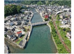
河川改修が完了した津久見川
