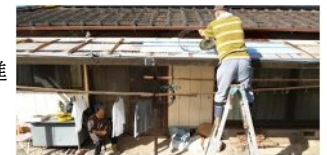
住民参加型福祉サービスによる屋根の補修
