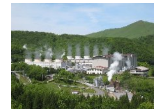
九州電力(株)八丁原発電所
