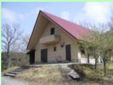
管理棟（事務室・用具倉庫）
