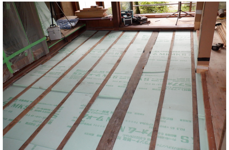
床断熱材 施工中
