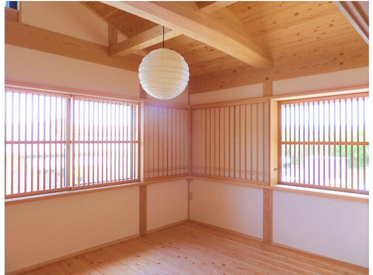
開口部は多層構成で障子と格子網戸を設置
