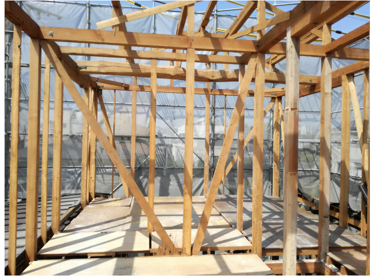
軸組を残して解体
