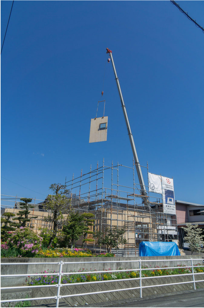
地域パネル工法 上棟の様子
