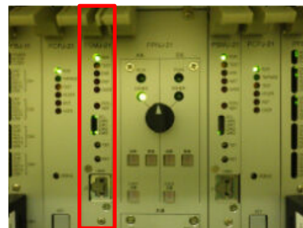
当該カード (取替箇所)
