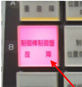
「制御棒制御盤故障」点灯
