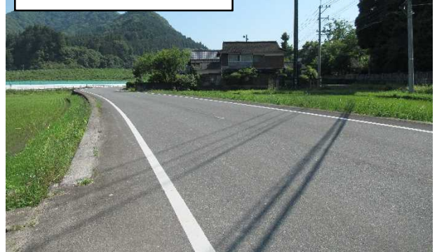
避難路（県道落合斉藤線）
