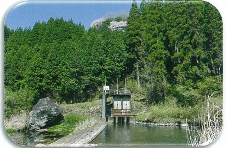
大野川頭首工（富士緒井路土地改良区）
