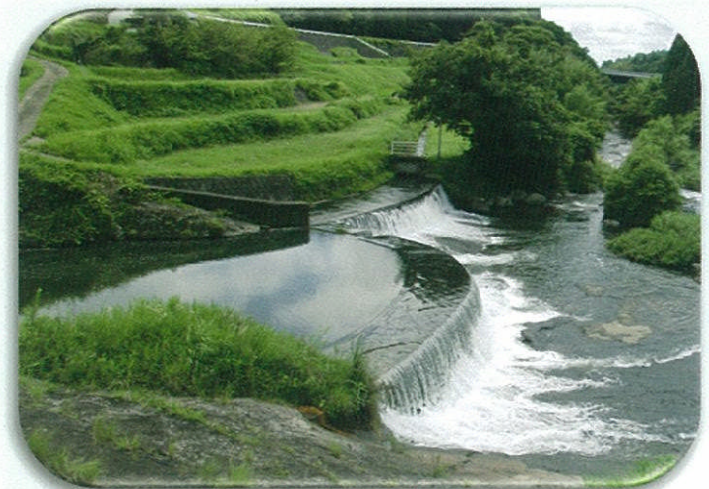
神田頭首工（城原井路土地改良区）
