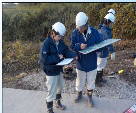
工事現場で打ち合わせ中
