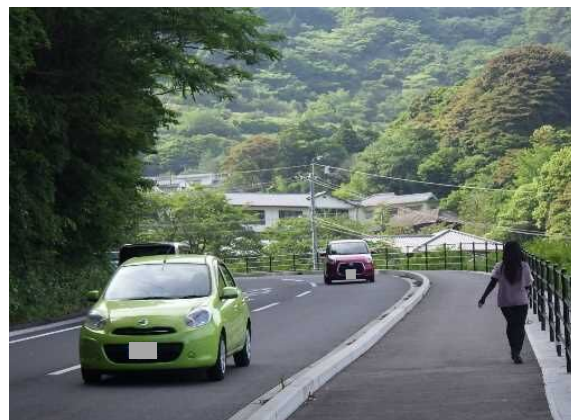
▲ 国道500号 (明礬工区 歩道設置) 別府市鶴見
