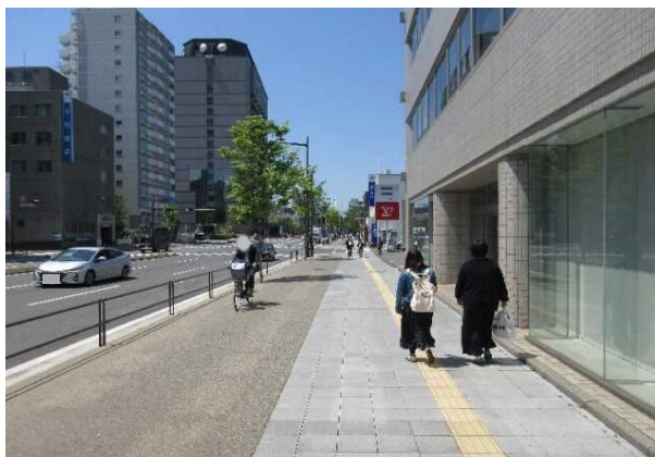
▲ 国道197号 (昭和通り工区 歩道改修) 大分市寿町～舞鶴町
