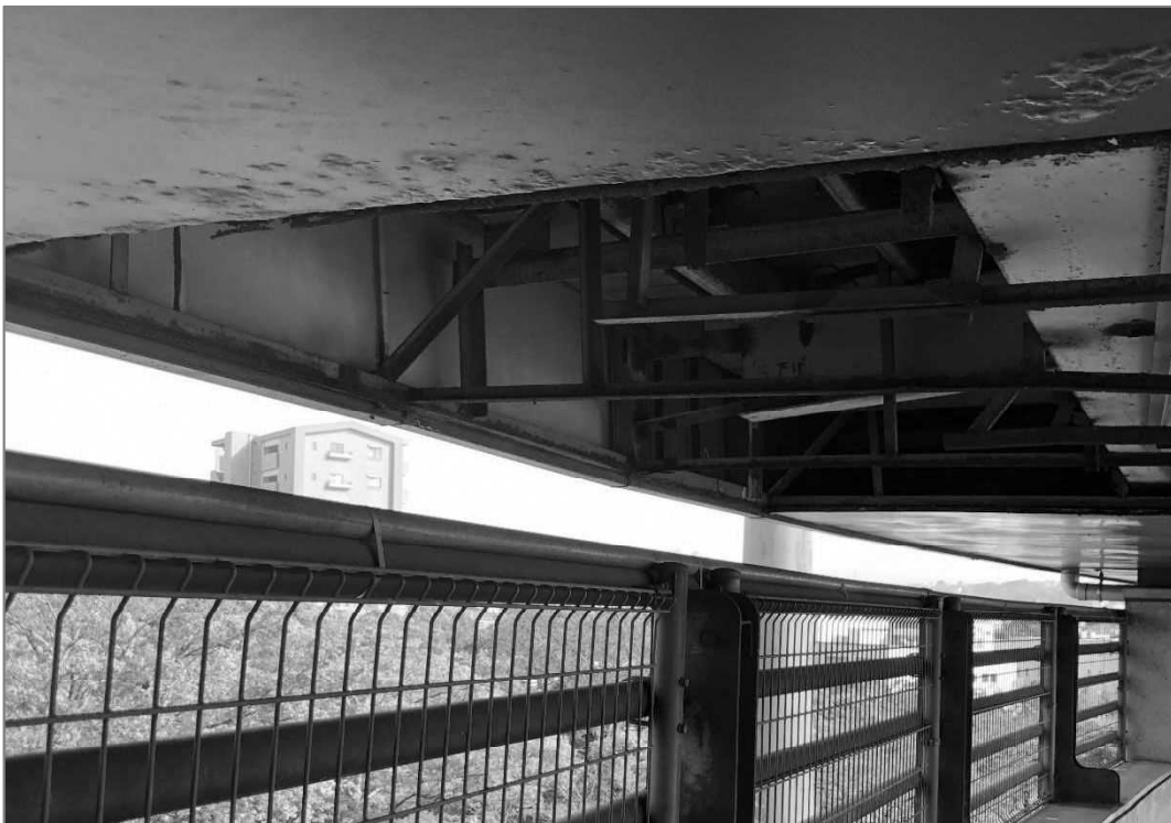
天井板を撤去し、今後修繕が行われる箇所（本塁側観客席最後部）
