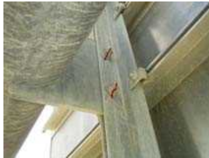
標識板取付部
