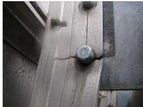
取付部の変状状況
