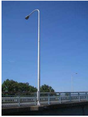
橋梁部に設置
