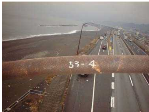
写真-解 8-11 支柱本体の腐食事例
