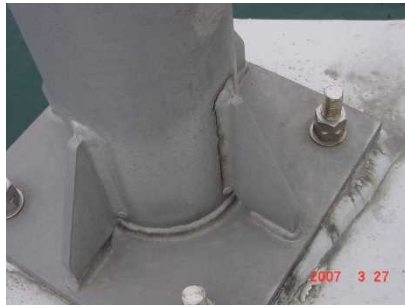
標識柱基部溶接部の亀裂 写真-解 8-4 支柱基部の亀裂事例
