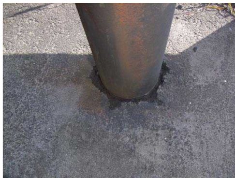
腐食、路面付近での滞水
