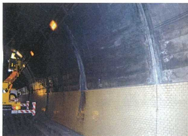
付図-1. 5 覆エスパンの中間付近に発生する変状の例
