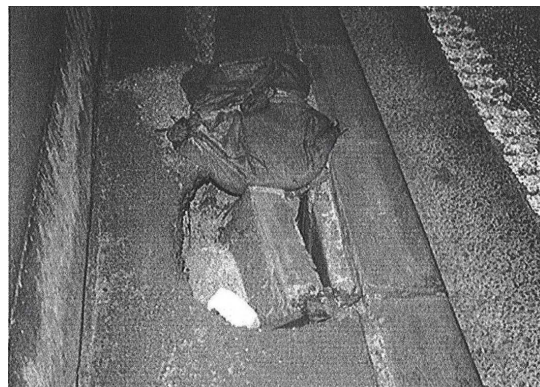
付写真-2. 4 (左) 盤ぶくれ状況(例)、(右) 路肩側溝の変状状況(例)
