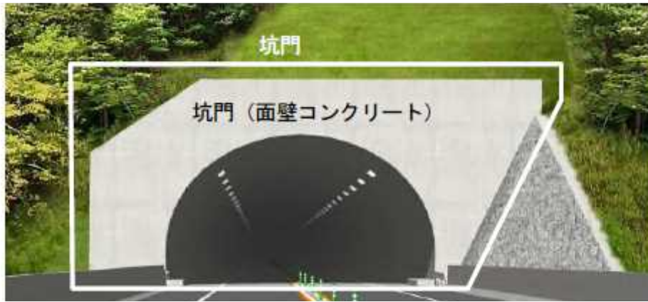
図-解 7.11 点検対象箇所（トンネル坑口部）
