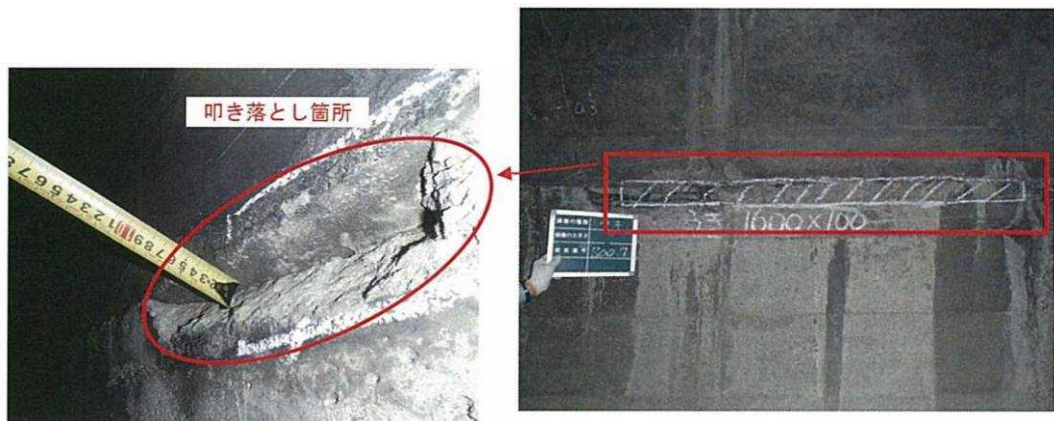
(b) 目地モルタルの例
