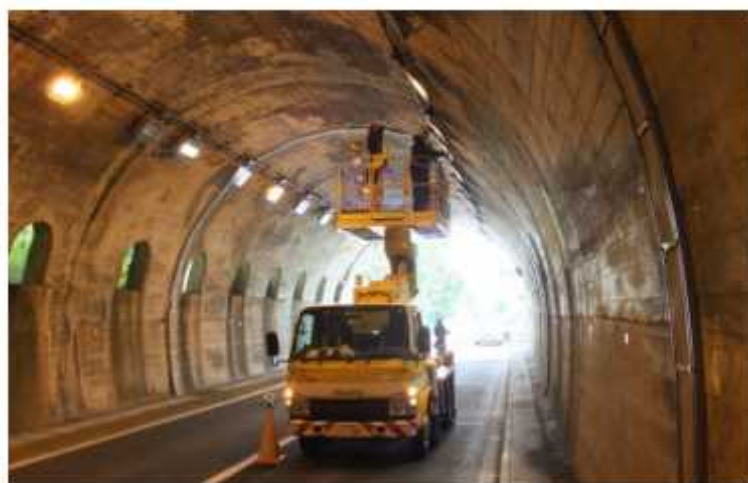
写真-解 7.2 近接目視作業状況
