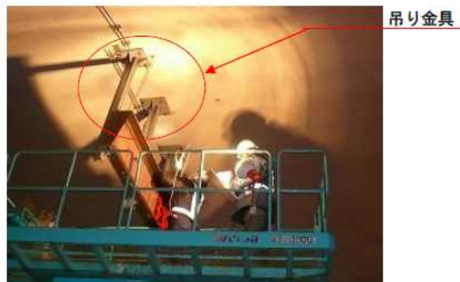
写真-解 7.2 触診作業状況
