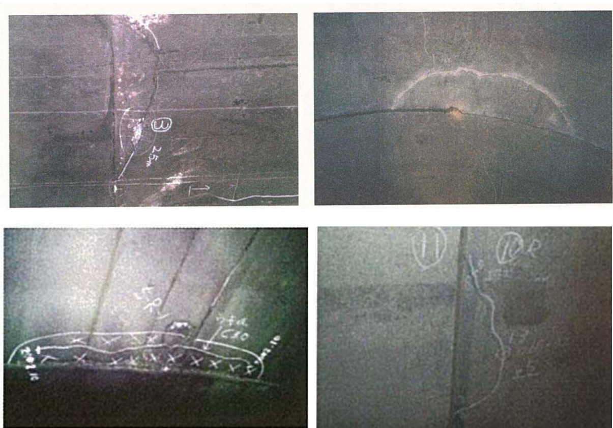
付写真-1. 1 横断目地の天端付近に発生した半月状のひび割れの例
