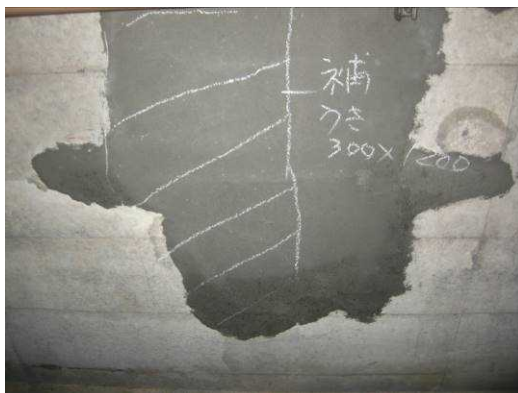
写真-解 1.2 歪な形の断面補修材の状況(例)
