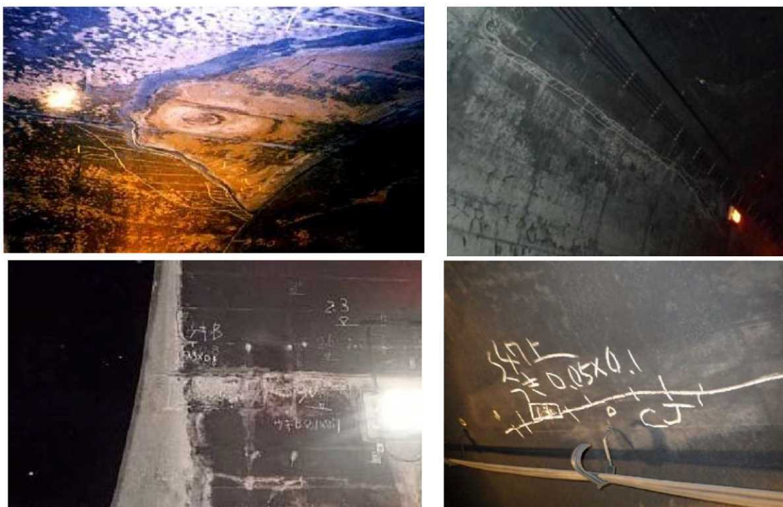
付写真-1. 12 コールドジョイント付近に発生したひび割れの例
