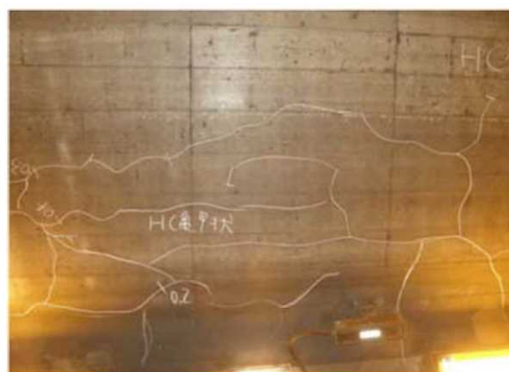
付写真-1. 5 複数のひび割れで覆エコンクリートがブロック化している例
