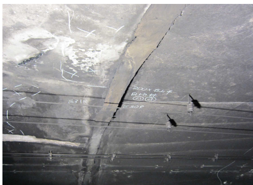
写真-解 1.3 目地補修材のはく離状況(例)
