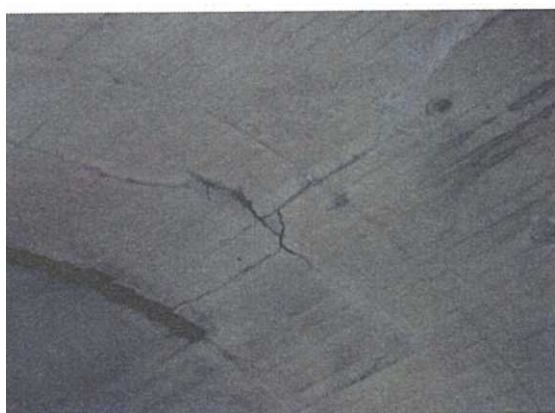
付写真-1. 5 複数のひび割れで覆エコンクリートがブロック化している例
