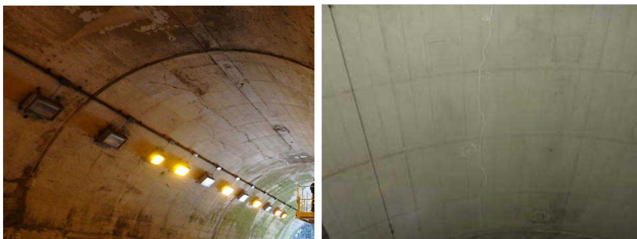
付写真-1. 3 覆工の天端付近に発生した縦断方向のひび割れの例
