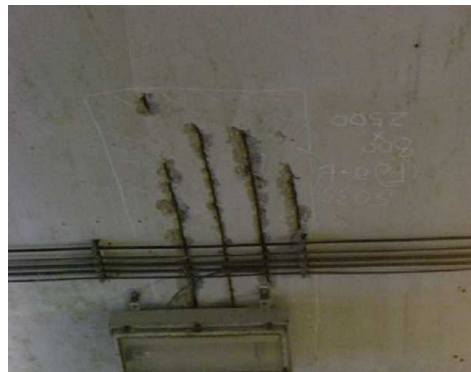
付写真-2. 2 鋼材腐食の例
