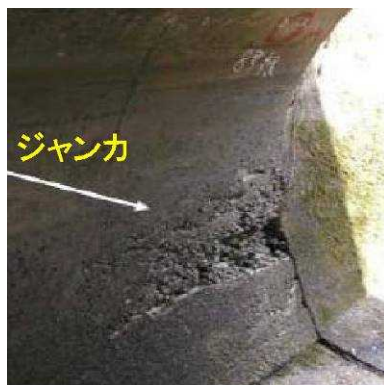
写真-解 1.4 ジャンカの状況写真(例)
