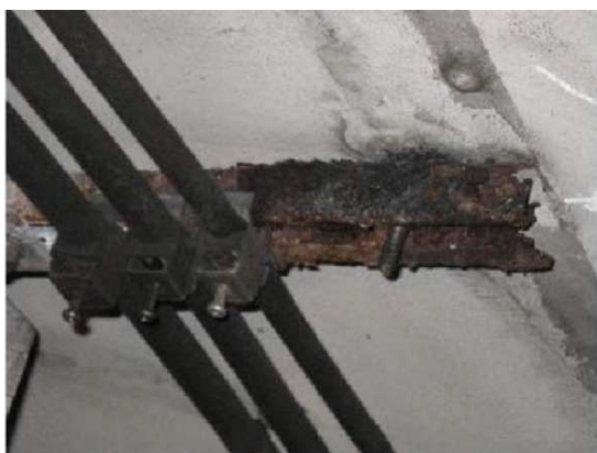
付写真-1. 13 固定金具の腐食とアンカーボルトの脱落の例
