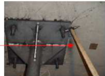
打音検査の例
