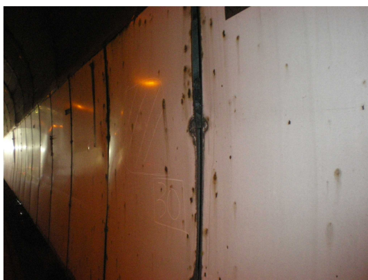
付写真-2. 5 内装板の破損状況(例)
