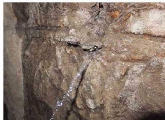
付写真-1. 7 漏水（噴出）している例
