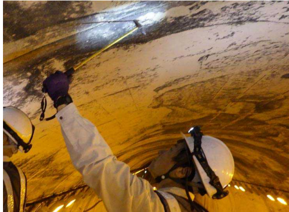
(a) トンネル本体工
