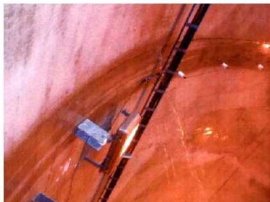
付写真-1. 7 漏水（噴出）している例
