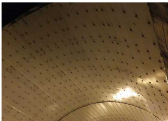
付写真-1. 11 鋼板接着（左）・繊維シートの接着（右）例
