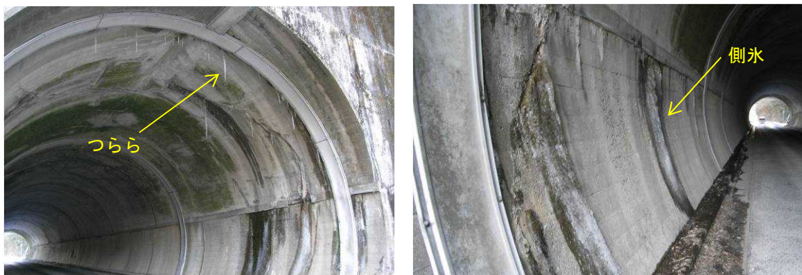
付写真-2. 3 トンネル内のつらら・側氷状況(例)
