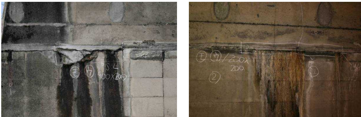
写真-解 1.1 水平目地のうき状況(例)
