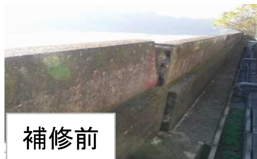
堤防張ブロックの破損(遠景)
