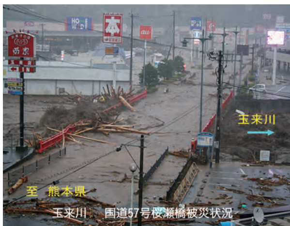
〔平成24年九州北部豪雨による被災状況〕
