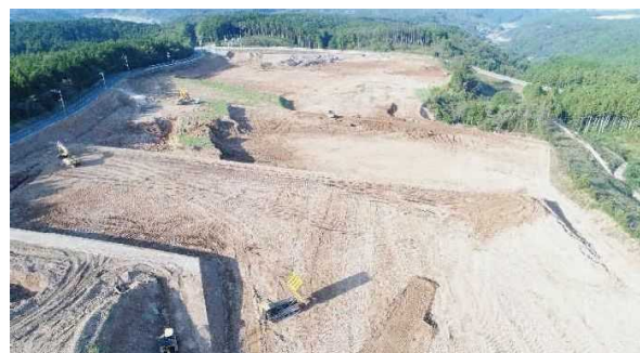
茶園造成工事の進捗状況(11月時点)
