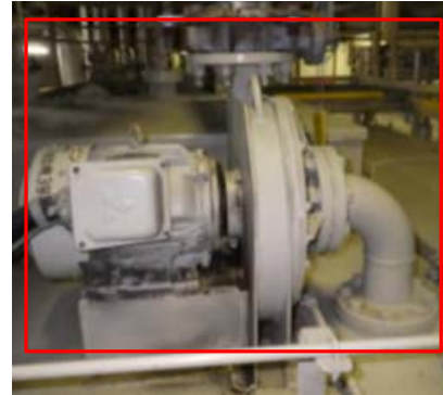
油清浄器ガス抽出機 (排気ファン)
