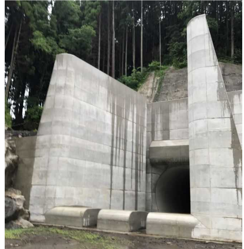
転流トンネル施工状況(平成28年度完成)
