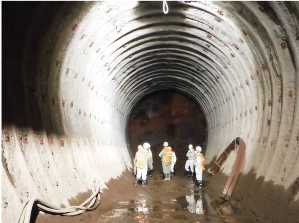
転流トンネル施工状況(平成26年度着手)
