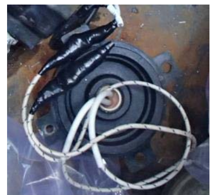
感知器端子箱内部 (手入れ後)
