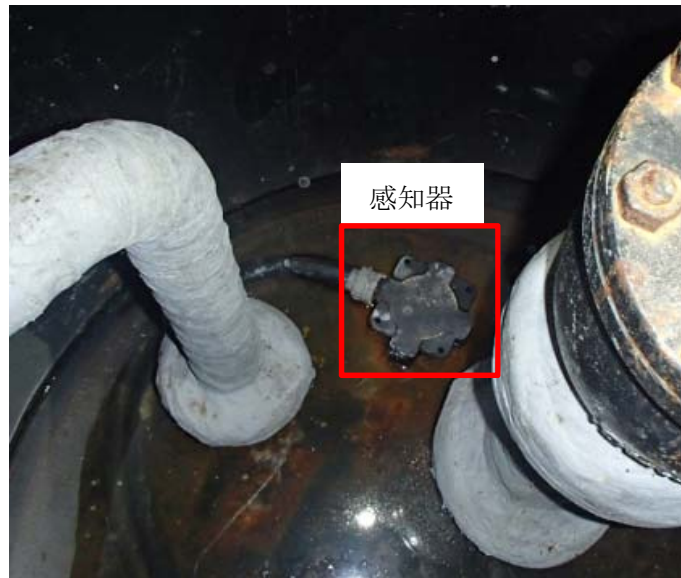
マンホール内部 (浸水時)
