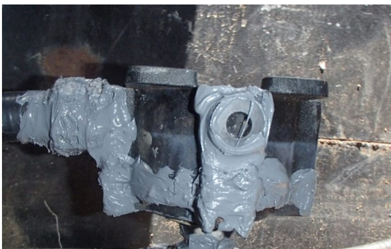
感知器端子箱防水処置
