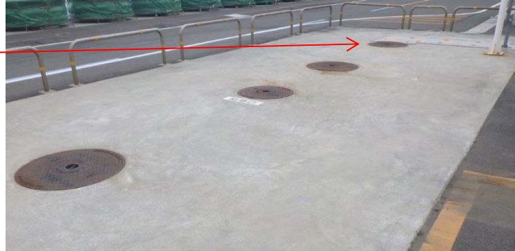
補助ボイラ燃料タンク外観
