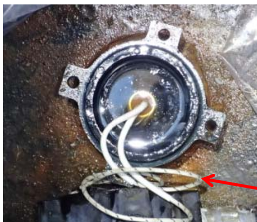
感知器端子箱内部 (浸水時)
