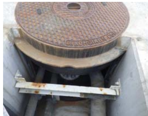
配管ダクトとマンホールの地上面の接続部 (配管ダクト蓋取外し)
