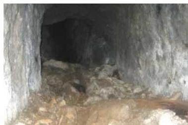
素掘水路トンネル内の崩落状況
