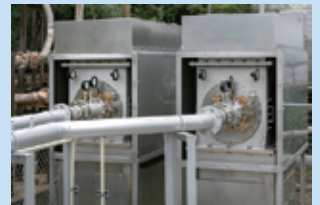
湯けむり発電システム 【地熱ワールド工業(株)】
