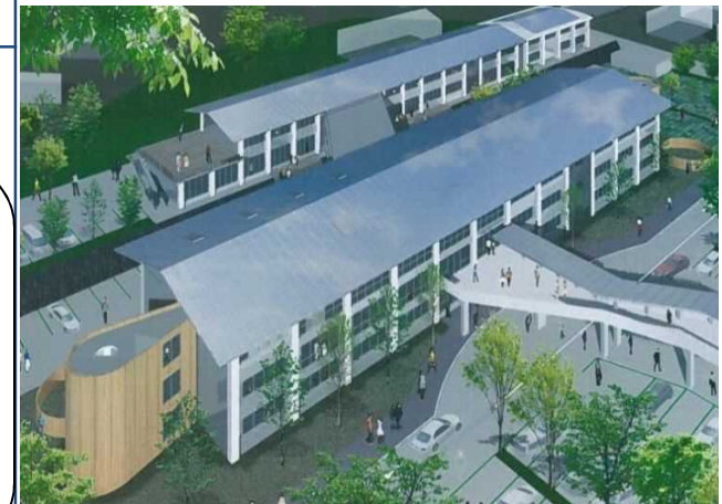
大規模改修工事後の教育センター(H27. 3)
