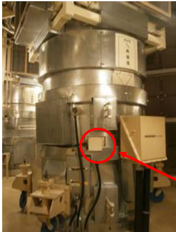
格納容器再循環ファン 3 A
