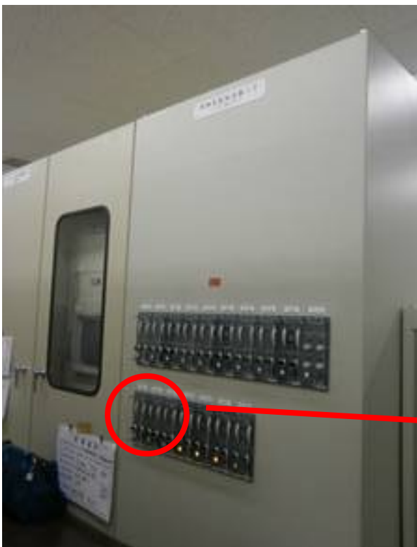
補機振動監視盤
