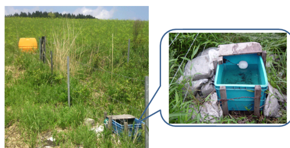
図3 放牧地における簡易給水設備
