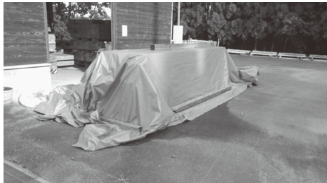
写真-1 散水養生の状況
