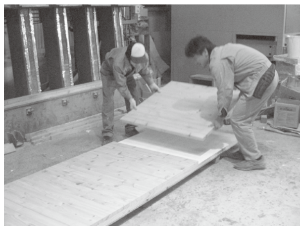
写真-4 3層3プライ CLT の試作
