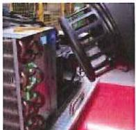
配管内に蛍光剤を注入し、漏えい箇所から漏れ出した蛍光剤を紫外線等のランプを用いて漏えい箇所を特定。
