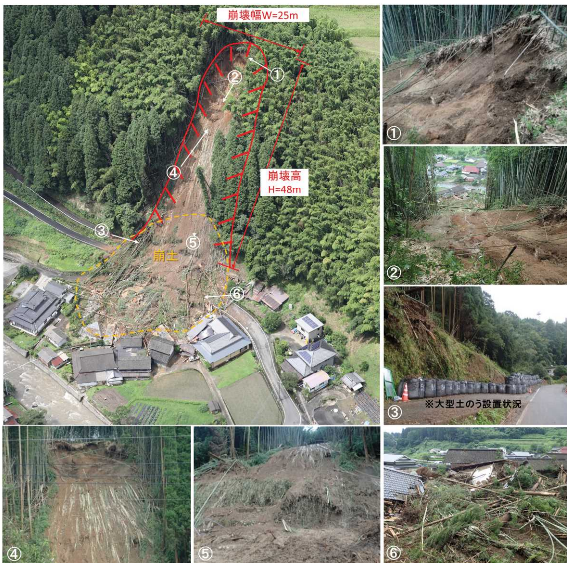
災害関連緊急急傾斜地崩壊対策事業（杉河内地区）
