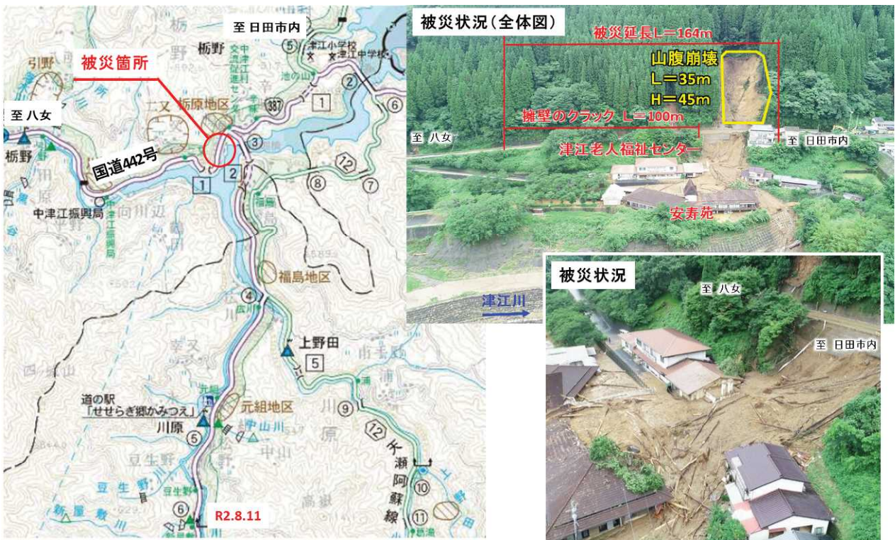
国道442号【県管理】（中津江村栃野）
