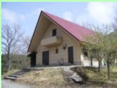
管理棟（事務室・用具倉庫）
